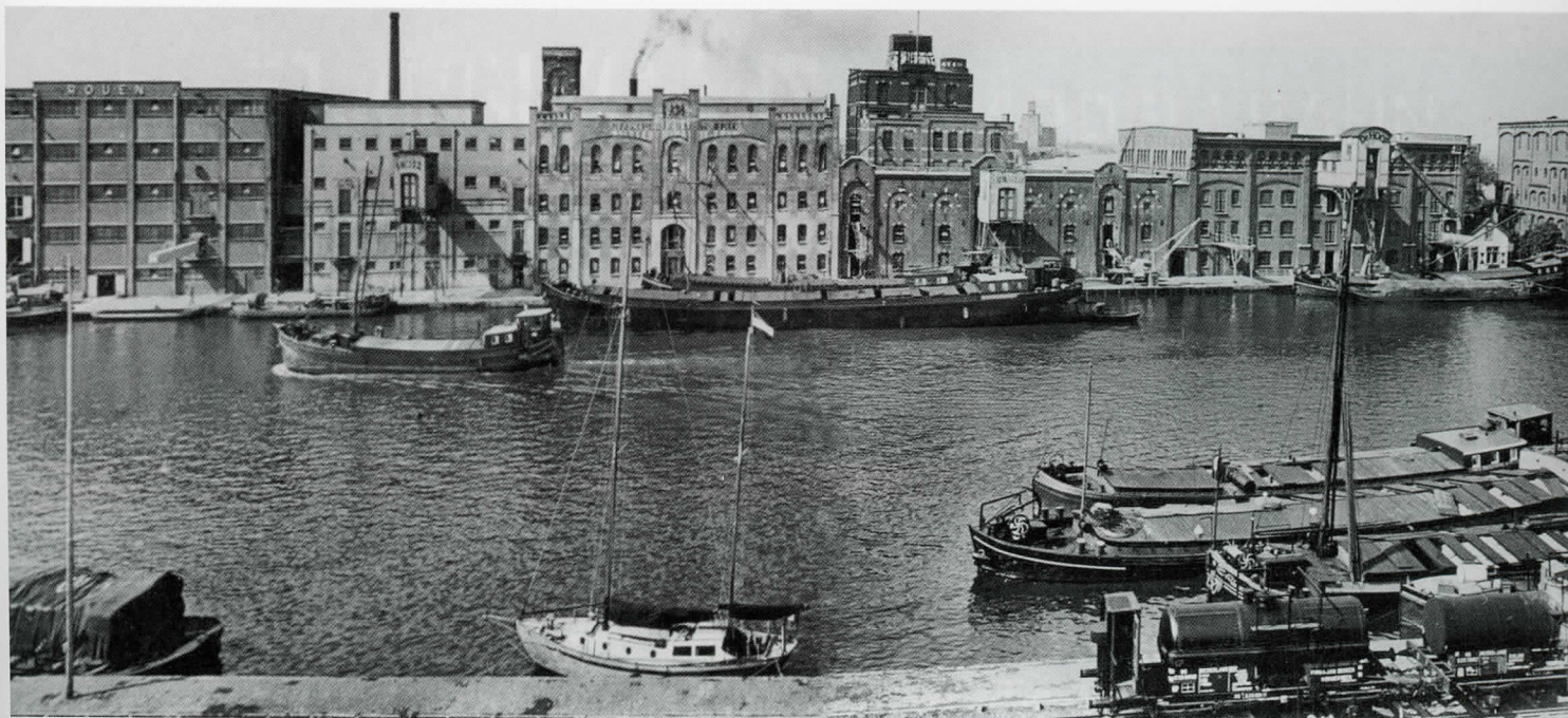
Gezicht op de havenkade omstreeks 1952, met aan de overkant van de Zaan de pakhuizen die de zogenoemde Zaanwand vormen. Op de voorgrond staat ketelwagen 530 801 van de firma J. Dekker uit Wormerveer, ook wel bekend als zeepziederij "De Adelaar", met de bekende grote vogel op het gebouw. Deze wagen kwam in maart 1949 bij Dekker, die de wagen tweedehands uit Duitsland betrok. Toen het bedrijf in 1957 deel ging uitmaken van de Chemische Fabriek Naarden werd de wagen afgevoerd. Gemeentearchief Zaanstad
