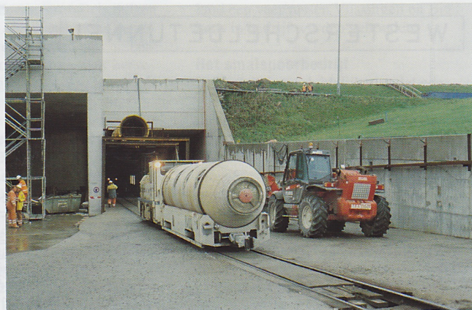
Loc TL13 duwt een groutwagen de oostelijke tunnelbuis uit; 6 november 2001. Foto: Gerard de Graaf.
