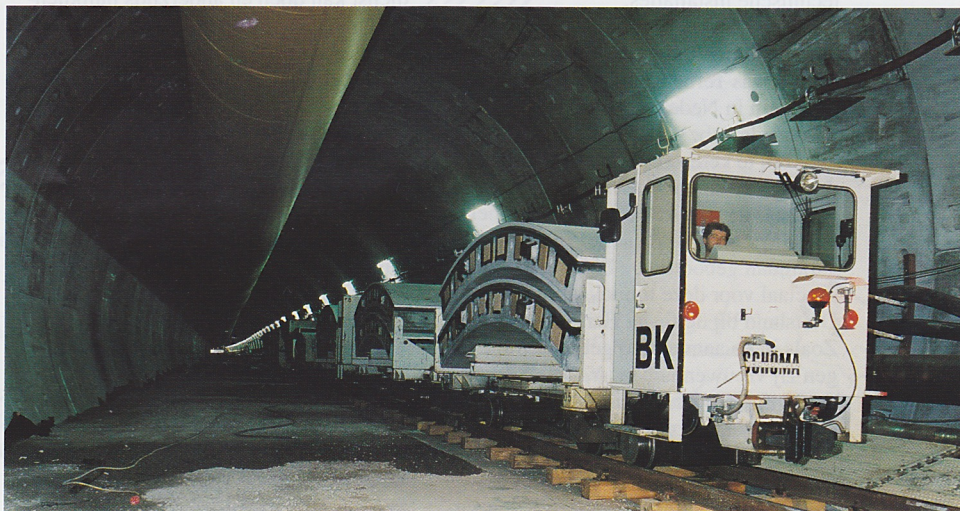
Aanvoer van tunnelelementen in de westelijke buis van de Westerscheldetunnel. De voorbereiding voor het toekomstige wegdek is reeds getroffen; 12 april 2000. Foto: Meetkundige Dienst Rijkswaterstaat.
