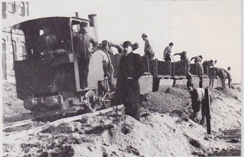
Jung-locomotief bij het zandstorten in de Grensstraat te Amsterdam; 20 februari 1896. Beide foto's: Gemeentelijke Archiefdienst A'dam.
