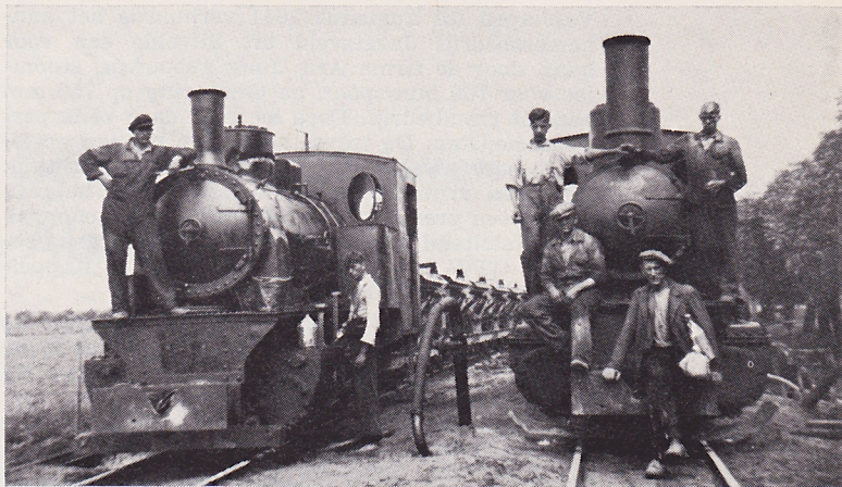
Het werk Autoweg Alblasserdam van de fa. Zanen-Verstoep; 1938. Links een loc van Linke Hofmann, rechts een van Jung, spoorwijdte 900 mm.
