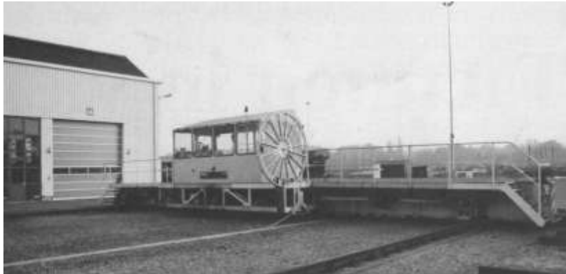
Rolbrug 2 met de nieuwe kabelhaspel (foto FP)
