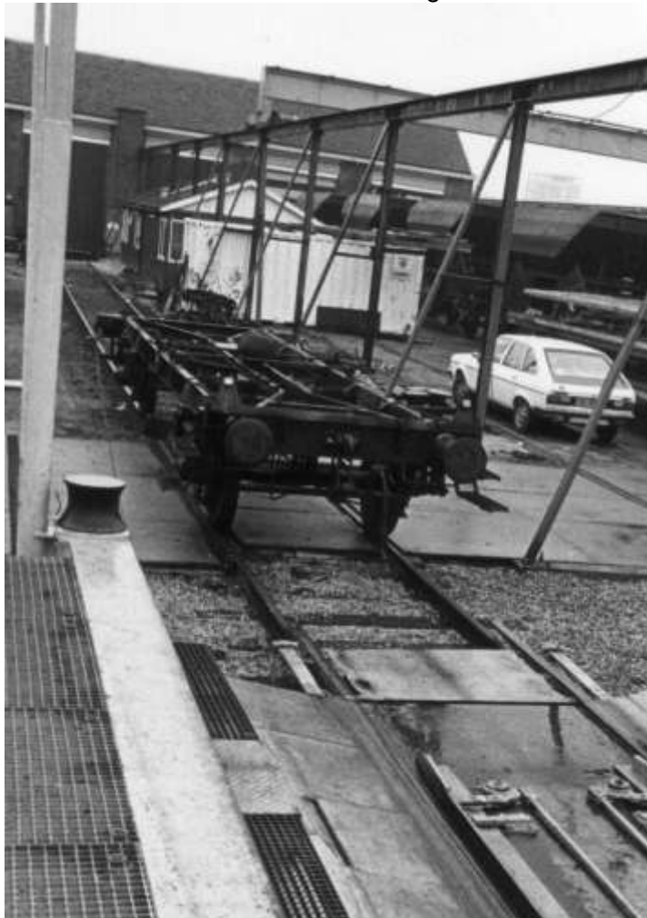
Een wagon wordt de brug opgetrokken (foto FP)
