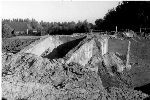
De tunnel is hier blootgelegd om gesloopt te worden
