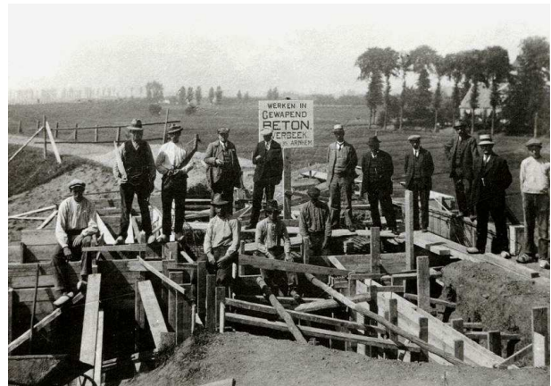
De aanleg van de tunnel door de Waaldijk (1920-1921)
