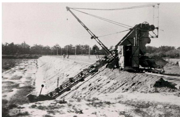
De excavateur (graafmachine) in werking bij Steenberg (gat van Smijers)
