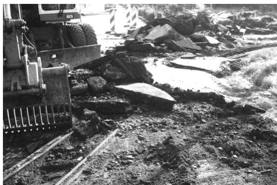
Bij de aanleg van een verkeersdrempel in de Nijmeegsestraat-Galgendaal kwam nog een gedeelte rails van het kleispoor tevoorschijn.
