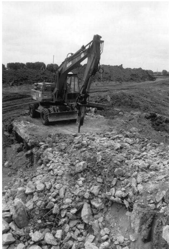
Het fijn trillen van de beton
