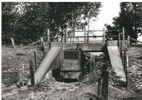
De machinist voert de locomotief met volle lorries door de tunnel naar de kleibult
