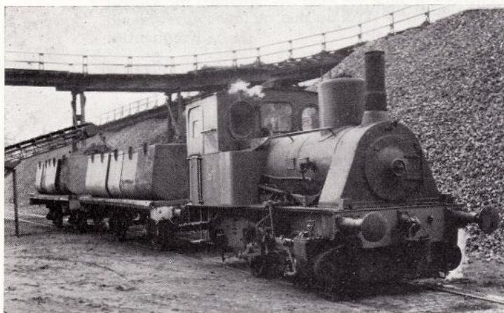
Gasfabriek Rotterdam, normaalspoor stoomloc 29 met wagens cokes; 13 april 1964 Foto 507.702 A H. de Herder
