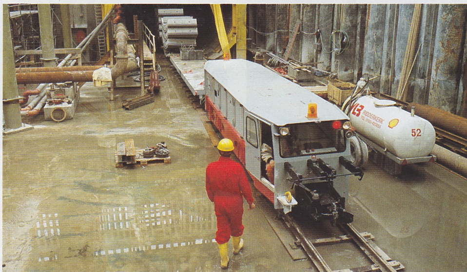
De GIA 2502 of 2508 brengt enkele wagens met segmenten voor de Heinenoordtunnel naar de boorinstallatie. Barendrecht, 26 maart 1997. Foto: Gerard de Graaf.
