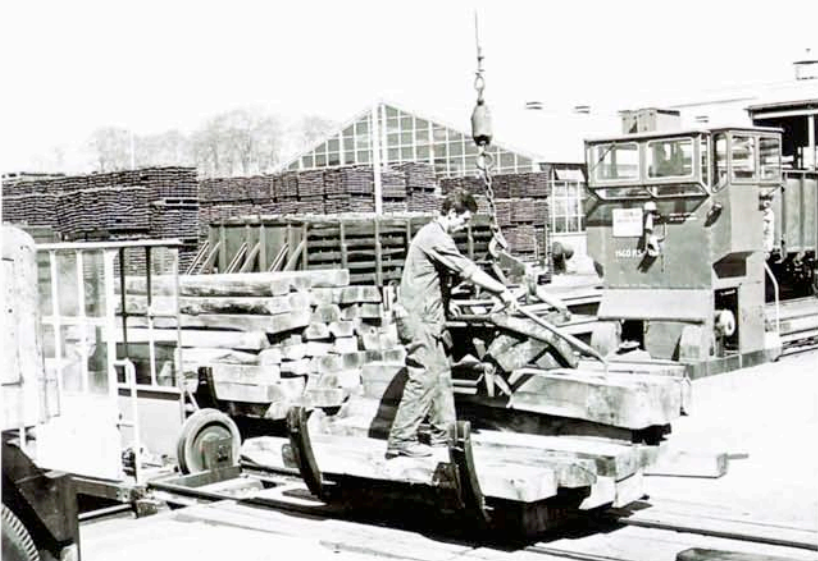
Het onbehandelde hout werd vroeger met behulp van een kraan op smalspoorlorries geplaatst en getransporteerd via een traverse (links); 24 april 1967. Foto: NS.
