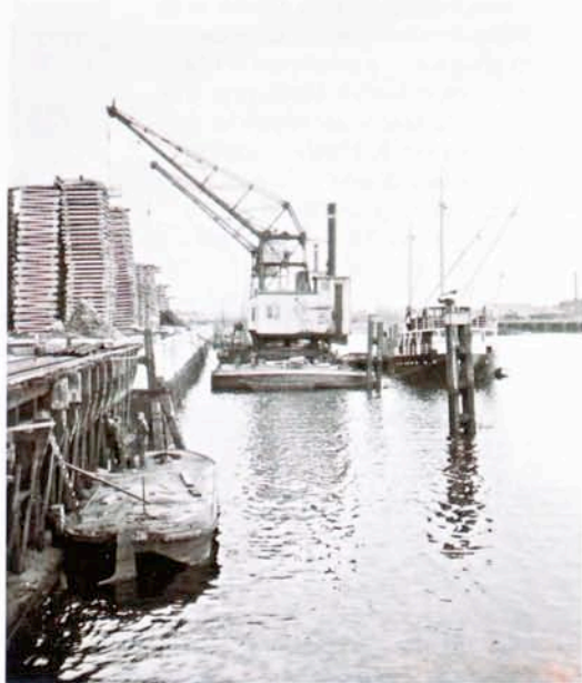
De aanvoer van hout voor de Houtbereidingsinstallatie geschiedde deels per schip. Foto: NS.
