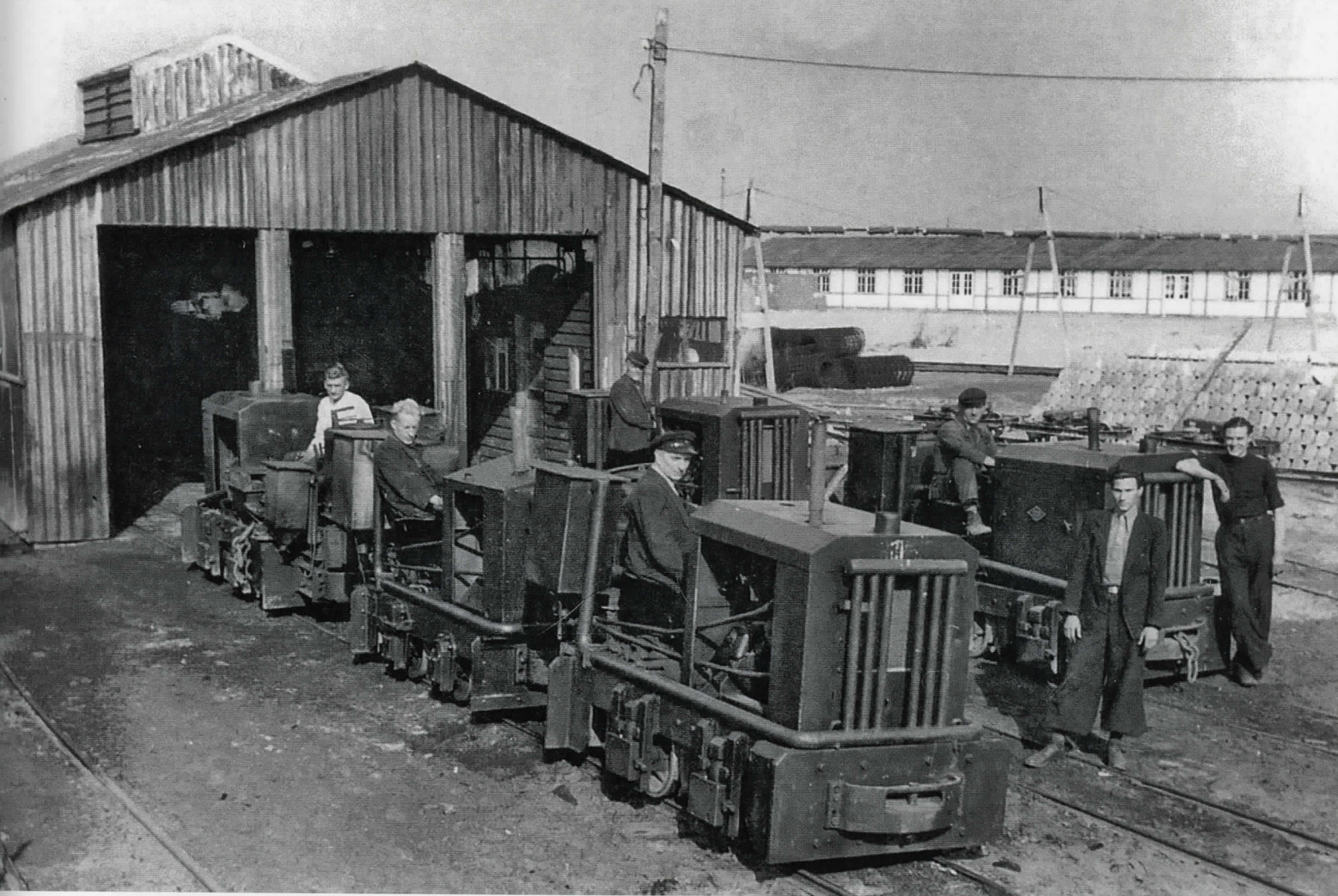
Voor de bouw van een fabriek van de Algemene Kunstzijde Unie in de Kleefse Waard bij Arnhem kwam er een vloot O&K MD 2 locomotieven naar Gelderland, daartussen verschuilt zich (tweede van links) ook een O&K type RL 1a. Arnhem, circa 1941. Foto: Collectie Gerrit Anneveld.
