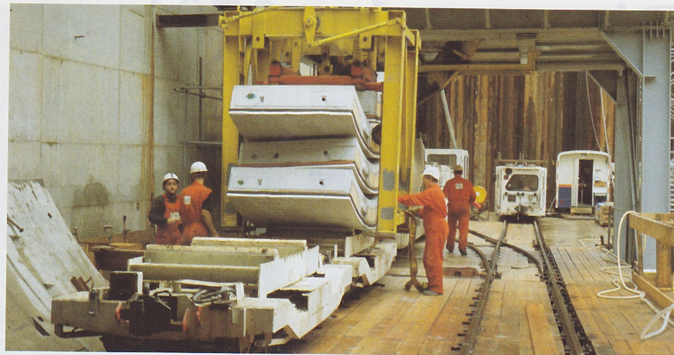
Een van de segmentwagens wordt beladen met een drietal segmenten. Hoogvliet, 24 september 1999.
