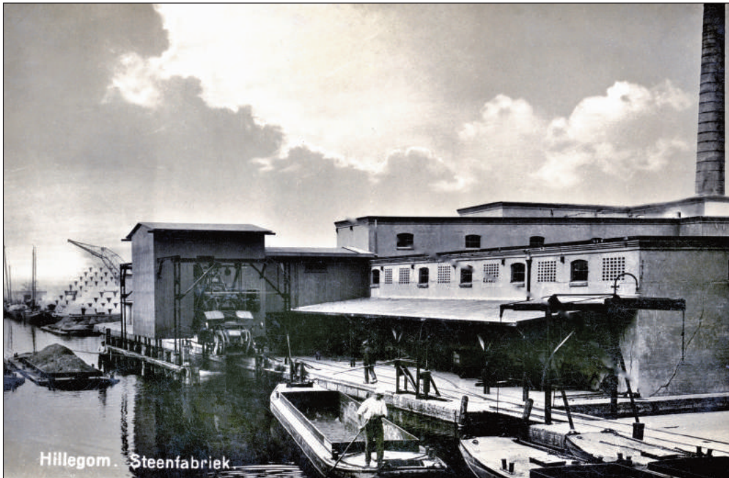
Het lossen van de zandbakken ging met hulp van een elevator. Het smalspoor kent in dit gedeelte ook een klapbrug. Hillegom, ca. 1932. Prentbriefkaart. Collectie: Gerard de Graaf.
